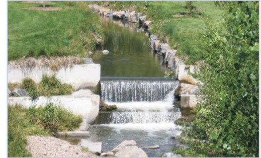
Caída vertical con muro de hormigón y cubeta de disipación protegida con enrocados.
