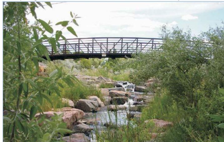
Caída protegida con enrocados consolidados manteniendo una apariencia natural.
